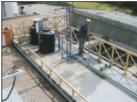
אתר לטיפול בשפכים תעשייתיים במפעל, והגידור הנדרש לנוכח הסיכונים (דוגמה)
