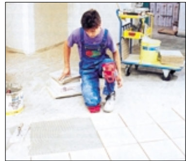
זירת הריצוף - כוללת מגיני ברכיים ושולחן חיתוך על עגלת שינוע
