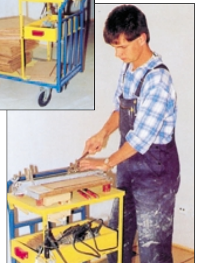
חיתוך מרצפות בעמידה על שולחן עבודה המורכב על גבי עגלת שינוע
