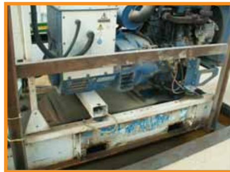
תמונה 15 : הארקה גישור גוף הגנרטור למינשא
