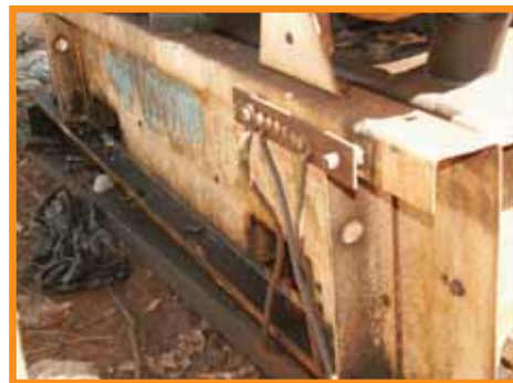
תמונה 16 : פס הארקה מותקן על המינשא של הגנרטור
